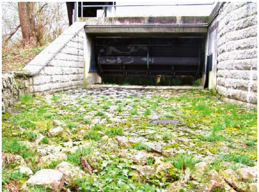
Bei einem häufigeren Eintreten von „Wolkenbrüchen“ in Folge des Klimawandels muss befürchtet werden, dass auch Mischwasserentlastungen vermehrt anspringen. Hier ein Foto einer Mischwasserentlastungsanlage an einem Hauptsammler in Freiburg. Wenn die Wehrklappen geöffnet werden, wälzt sich eine meterhohe Schmutzwasserflut den angrenzenden Bach hinab. Eine weitere Verschlechterung der Gewässergüte könnte durch eine stringente Realisierung des Schwammstadtkonzeptes vorgebeugt werden. (Foto: regioWASSER e. V.)
